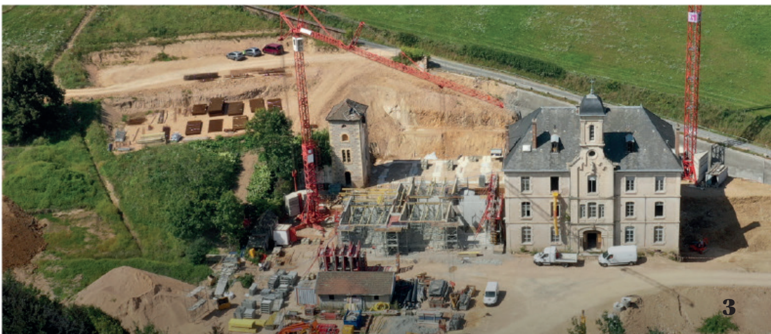
Septembre 2021 : Chantier Claveisolles (copyright OPAC du Rhône)
